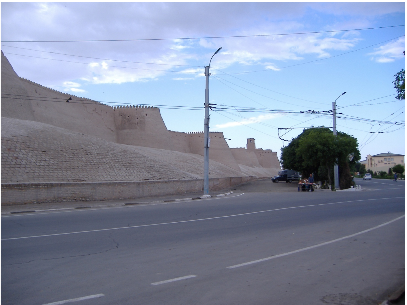
F.1. Vista esterna delle mura (in terra battuta)
